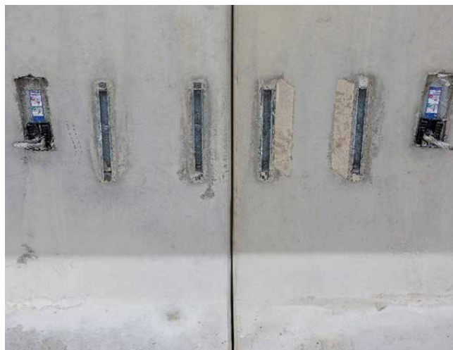
Halfenschienen als Verbindungsgrundlage
