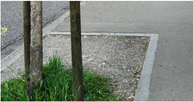
Ungeschützter Wurzelraum führt zu hoher Bodenverdichtung
