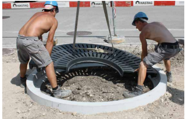
Versetzen der Gussroste
