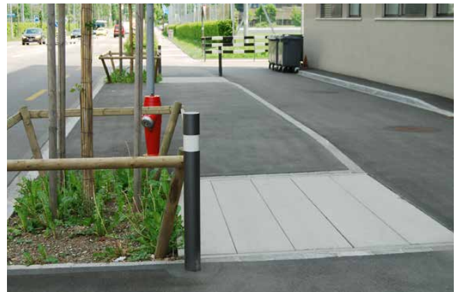
Einbau von Wurzelbrücken seitlich der Baumgrube
