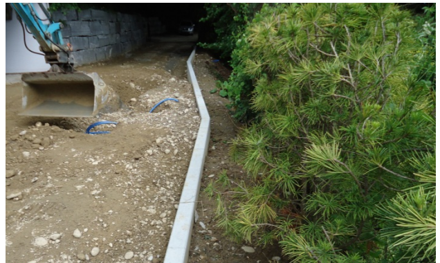
Bild 41: Lagenweises Einbringen von geeignetem Hinterfüllmaterial
