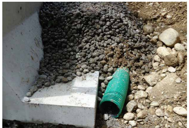
Bild 28: Einbau einer Sickerleitung mit Sickerpackung
